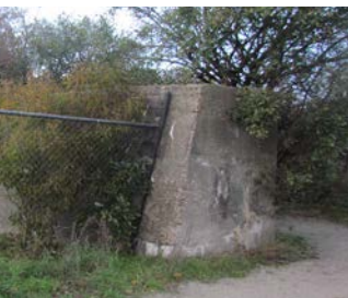
Restant van een tankmuur
