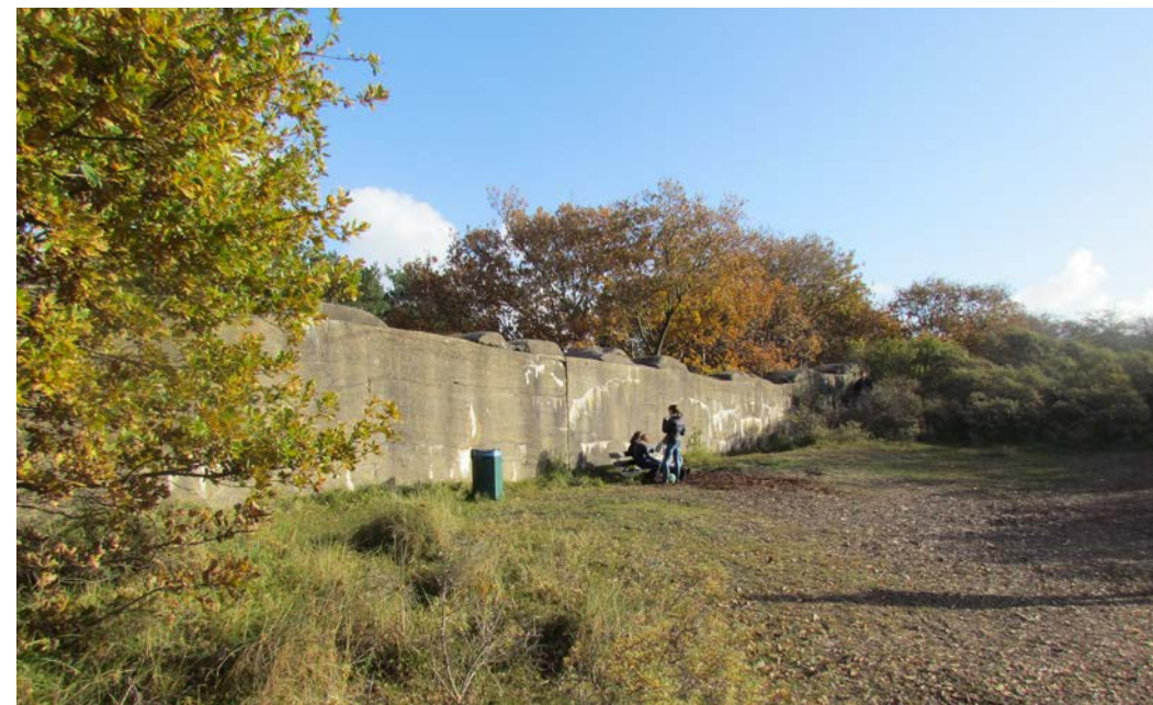
Onderdeel van de Atlantikwall waren hoge en brede tankmuren, een gedeelte daarvan is nog goed te zien in de Pan
